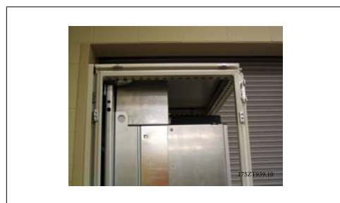
Рисунок 3.38: Верхний воздухопровод и установленный верх корпуса
