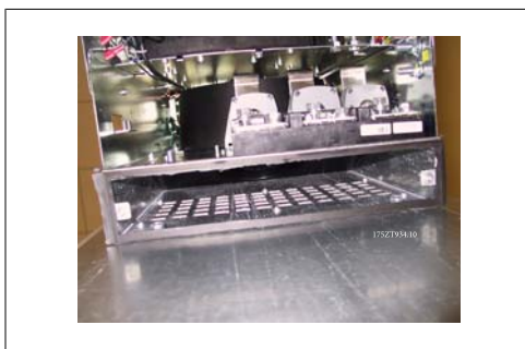
Рисунок 3.33: Установленный переходник нижнего воздуховода
