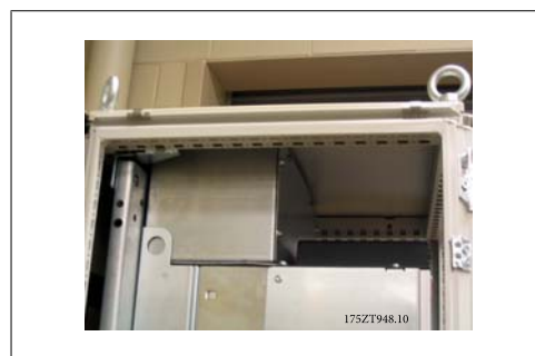
Рисунок 3.49: Установленный верх корпуса
