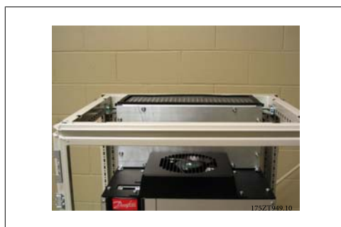
Рисунок 3.48: Установленная закрывающая пластина верхнего воздуховода
