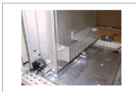
Рисунок 3.59: Установленный нижний воздуховод.
