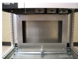
Рисунок 3.56: Установленный нижний воздуховод
