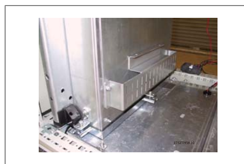
Рисунок 3.59: Установленный нижний воздуховод.
