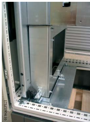
Рисунок 3.54: Временно установите воздуховод, чтобы произвести разметку выреза на уплотнении
