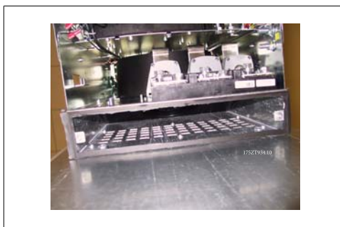
Рисунок 3.33: Установленный переходник нижнего воздуховода
